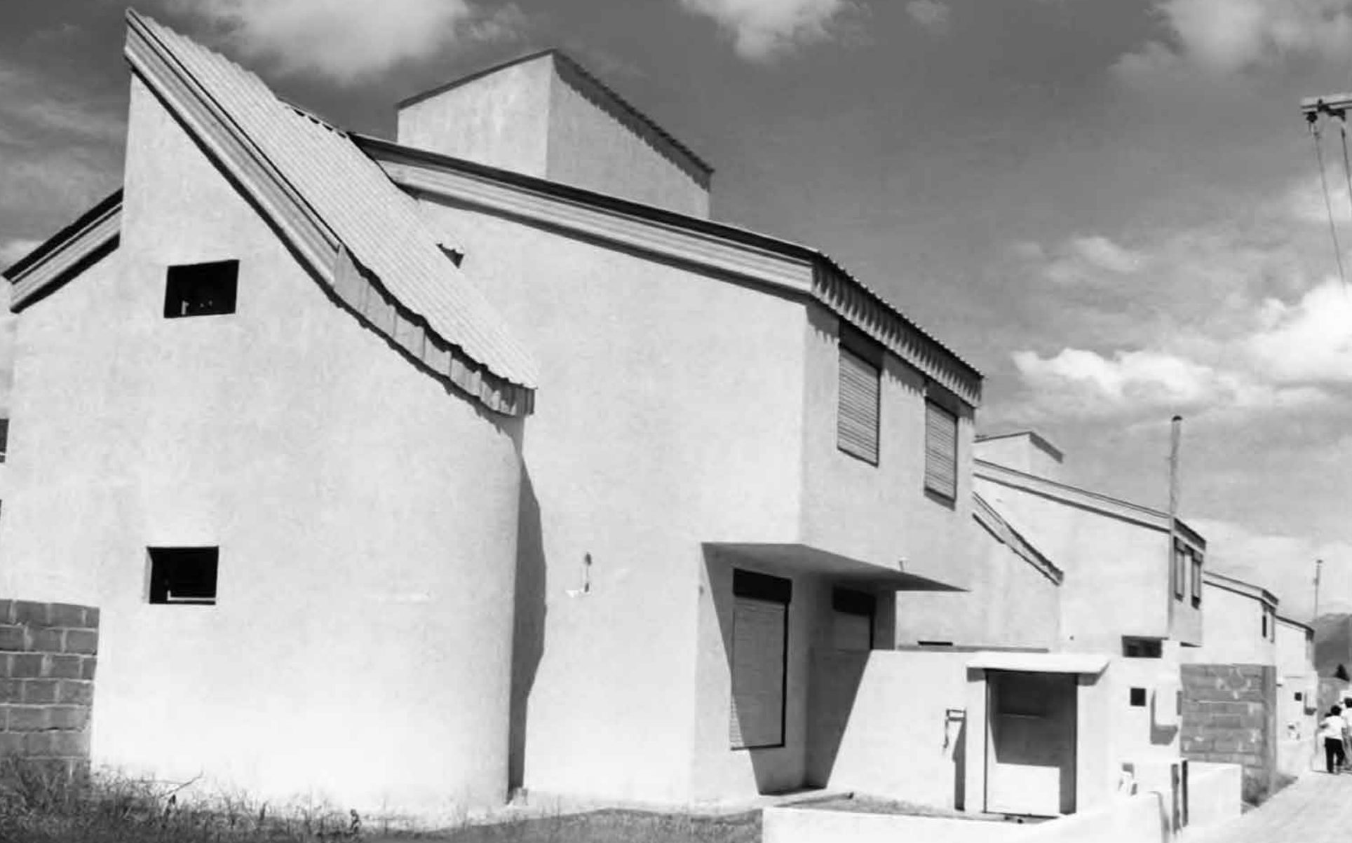
Barrio de 16 viviendas de Esquel, construido por el ISSyS e inaugurado por el Gobernador Néstor Perl. 1988.
